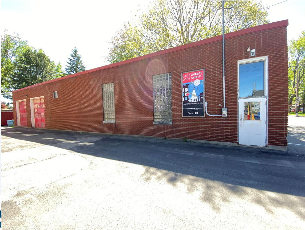
Façade latérale droite
